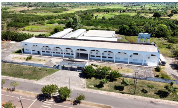
Figura 1 – Estrutura Física do IFMA, campus Bacabal
