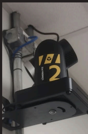
Câmera 2 desligada (apontada para trás e inclinada para baixo, sem luz no painel)
