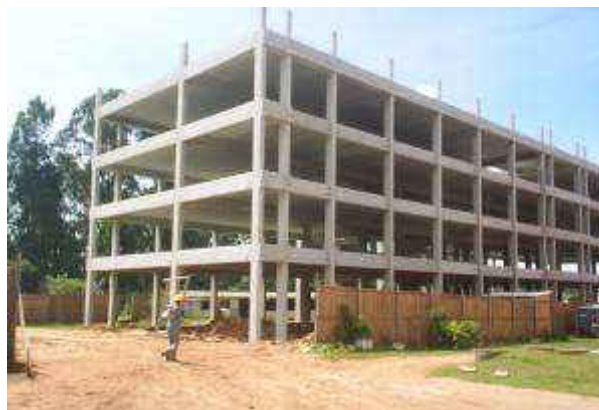
Figura 43 – Construção da 1ª etapa do Bloco B, Campus Ecoville
