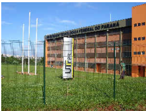
Figura 48 – Instalação da comunicação visual
