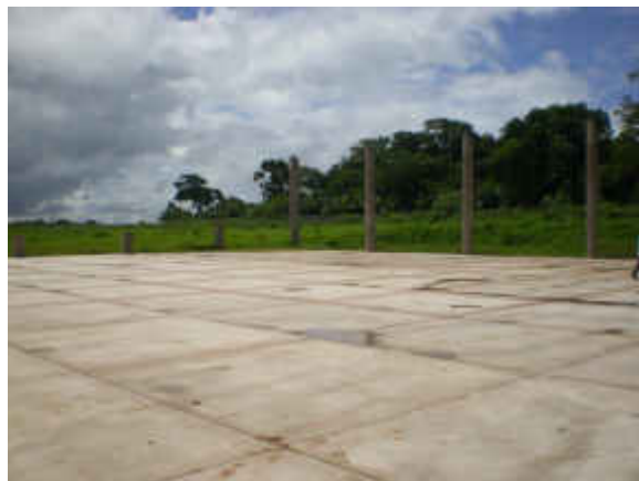
Figura 64 – Construção da quadra esportiva
