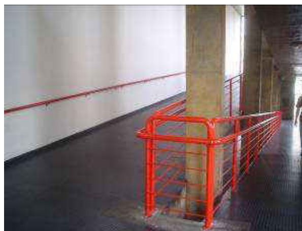
Figura 41 – Instalação de corrimão e guarda-corpo nas rampas do bloco E
