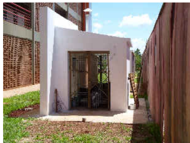
Figura 49 – Construção da Casa da caldeira
