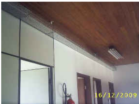
Figura 56 – Reforma elétrica do Bloco Z
