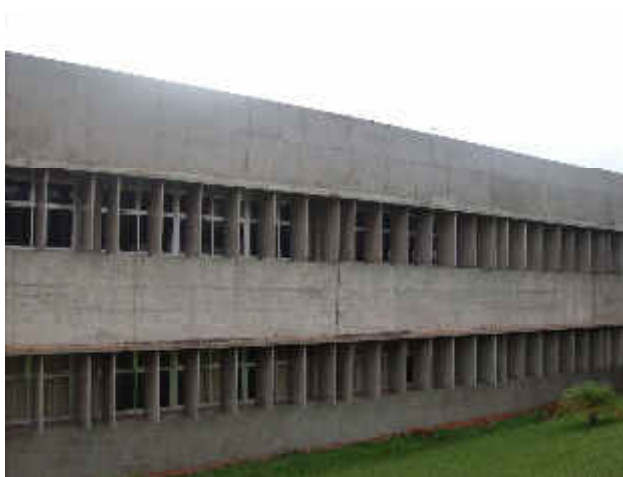
Figura 36 – Impermeabilização das fachadas
