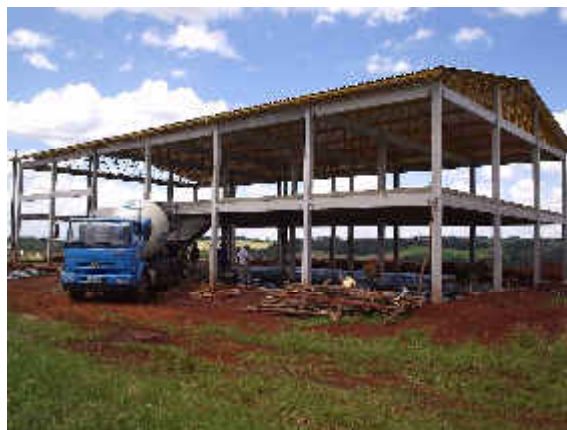
Figura 57 – Construção Bloco K1, para o Curso de Agronomia.
