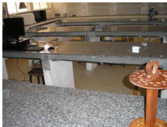
Figura 59 – Instalação de granito nas bancadas do Laboratório de Métodos
