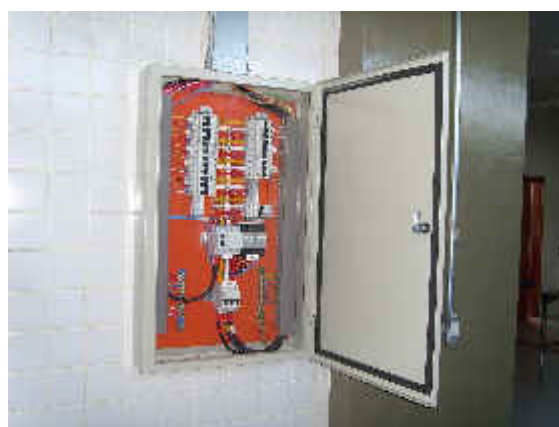
Figura 47 – Reforma das instalações elétricas do Bloco 03
