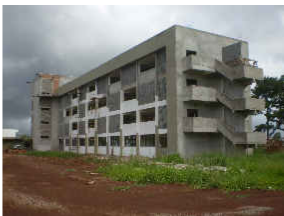
Figura 63 – Construção do Bloco A
