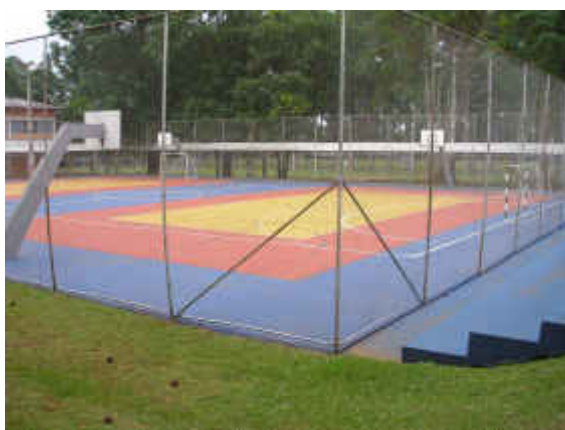
Figura 58 – Reforma da quadra esportiva
