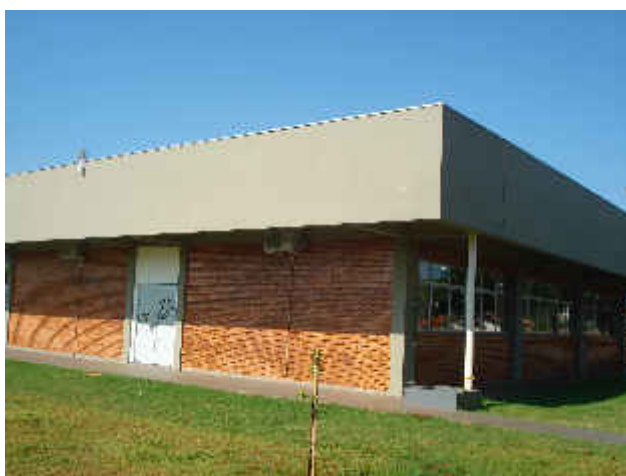
Figura 50 – Edificação do Bloco EAD
