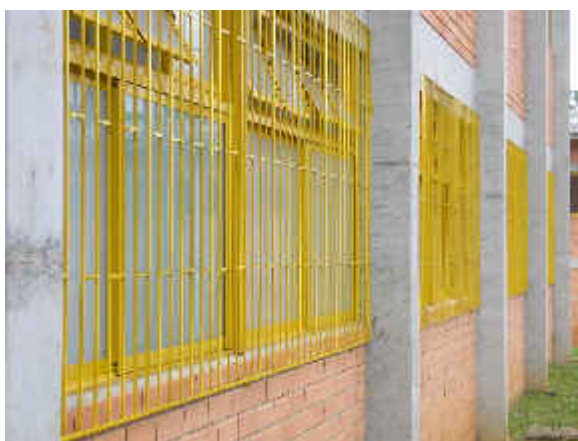
Figura 60 – Instalação de grades no Bloco G
