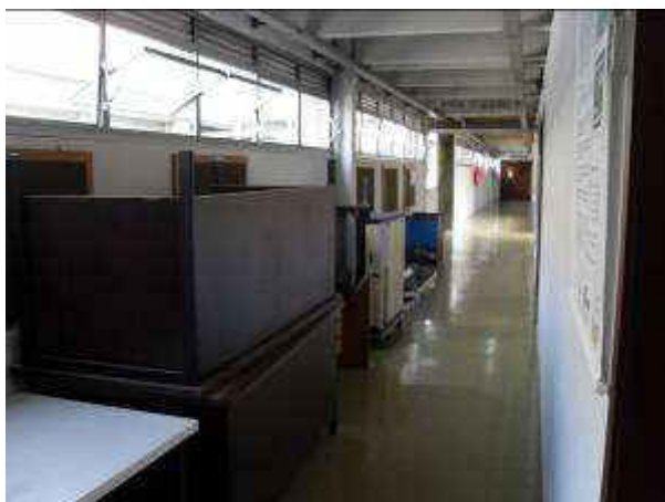
Figura 38 – Reforma do laboratório B305
