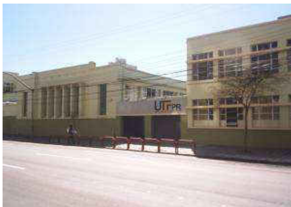
Figura 42 – Pintura das fachadas externas
