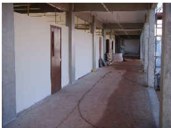
Figura 46 – Execução da 2ª Fase do Bloco 07
