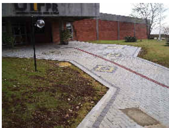
Figura 52 – Pavimentação do Hall de entrada
