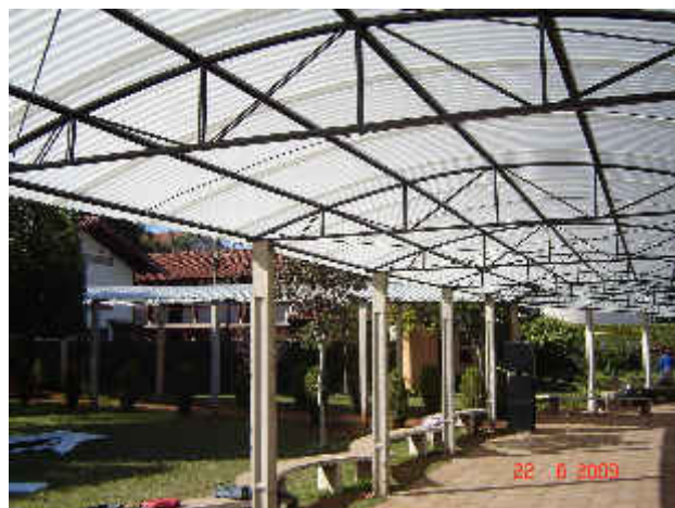
Figura 35 – Cobertura em estrutura metálica
