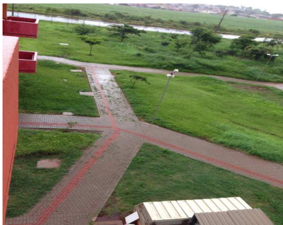
Figura 23 – Pavimentação da área urbanizada em pavers
