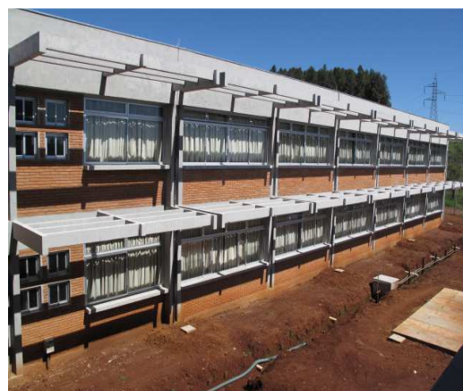
Figura 28 – Ampliação dos Blocos L M e N
