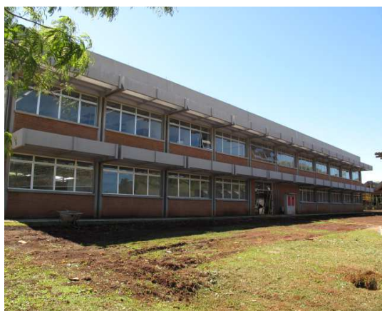
Figura 27 – Construção Bloco J1
