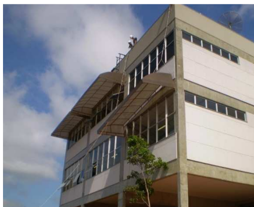
Figura 18 – Bloco CIPECA/ instalação de toldos
