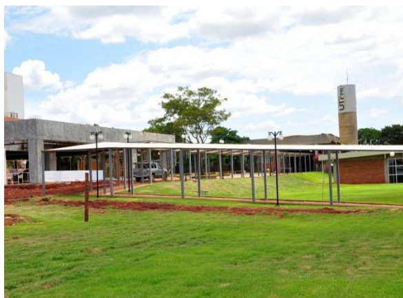
Figura 25 – Execução de cobertura de acesso blocos
