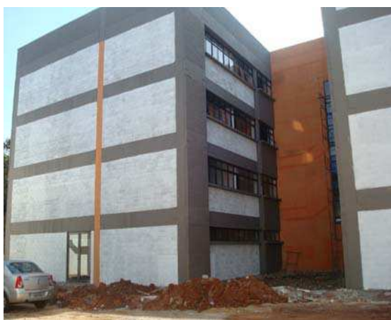
Figura 19 – Construção Bloco EF – Sede Ecoville
