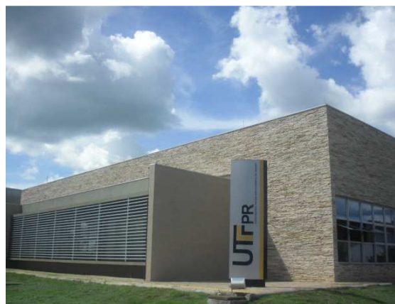
Figura 22 – Construção do Bloco K/setor administrativo
