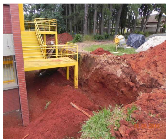
Figura 30 – Construção do muro de arrimo Bloco L
