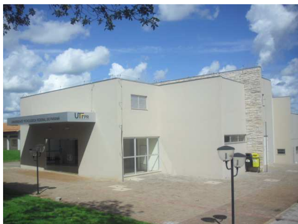
Figura 21– Construção do Bloco L/ auditório
