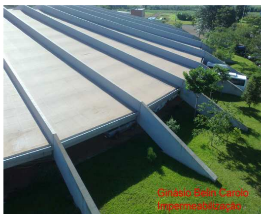
Figura 15 – Impermeabilização do Ginásio
