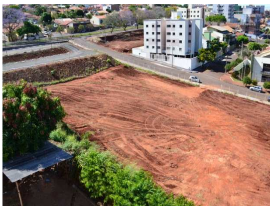
Figura 17 – Terraplenagem de terreno
