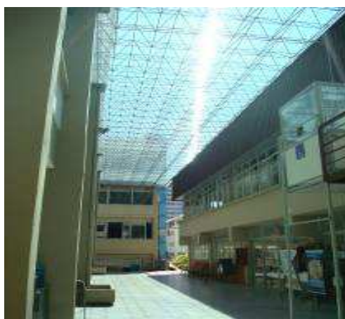
Figura 20 – Reforma das coberturas dos blocos da Sede Central
