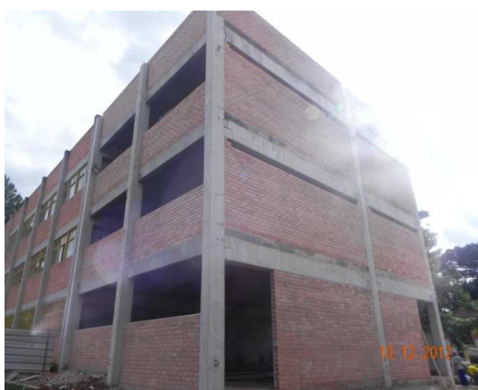
Figura 29 – Ampliação Bloco da Pós-graduação
