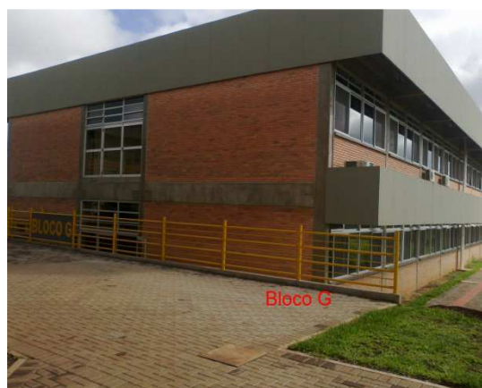
Figura 16 – Construção Bloco G
