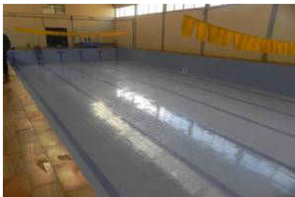
Figura 36 – Recuperação e reforma da piscina
