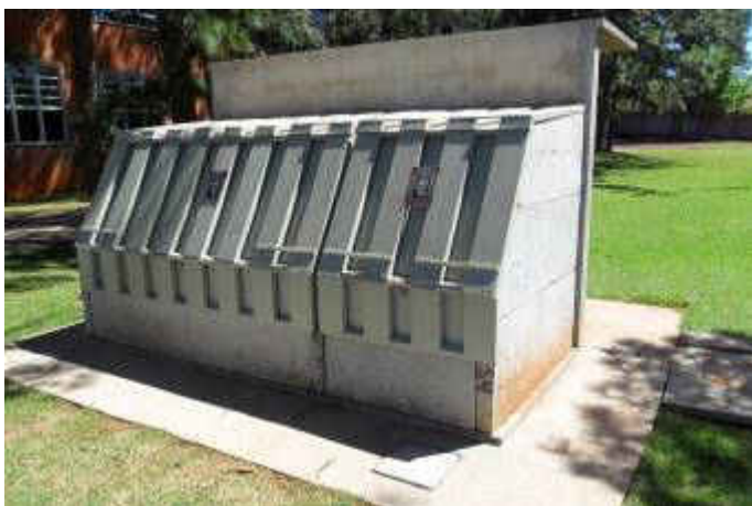
Figura 38 – Implantação de subestação de energia elétrica para atender ao RU, Ginásio e Biblioteca
