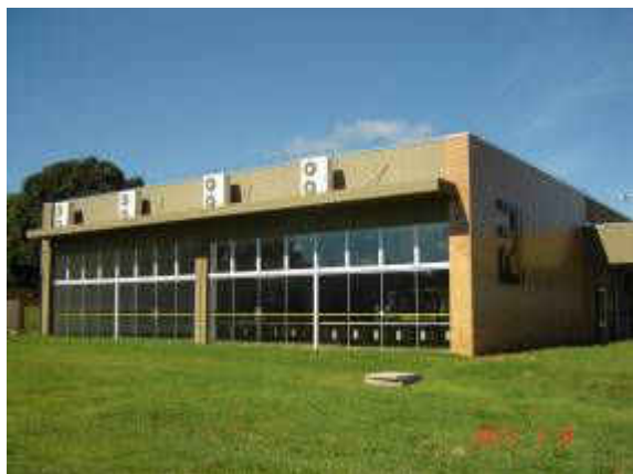
Figura 32 – Construção do RU
