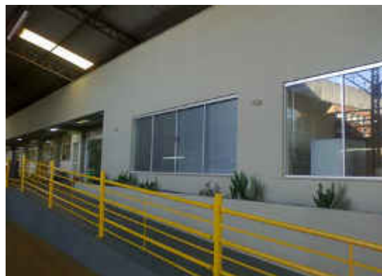
Figura 23 – Reforma do Bloco A
