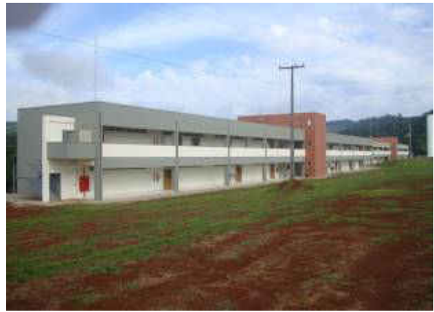
Figura 29 – Construção do Bloco G2
