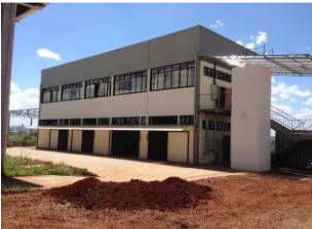
Figura 30 – Construção do Bloco S
