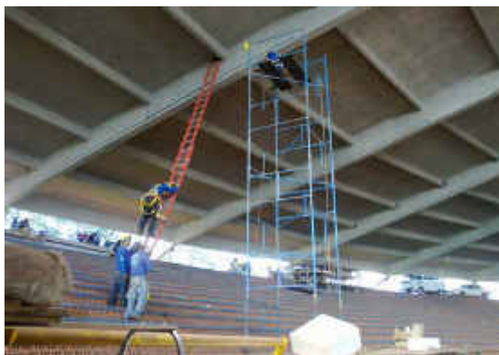
Figura 22 – Reforma elétrica do Ginásio
