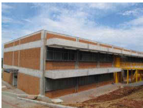
Figura 34 – Construção da 2ª etapa Biblioteca
