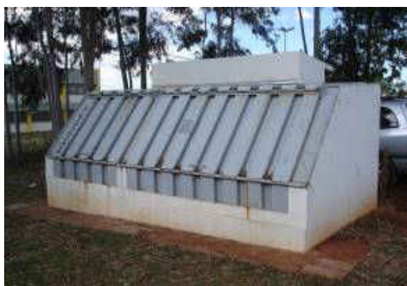
Figura 20 – Construção de subestação Bloco SE4
