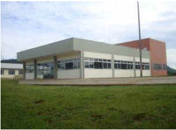
Figura 28 – Construção do RU
