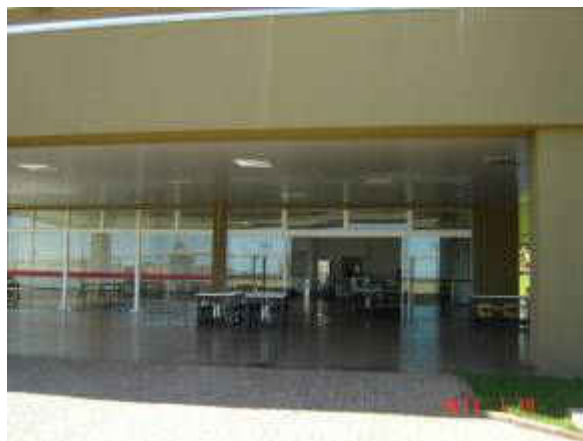
Figura 33 – Construção do RU (detalhe entrada)
