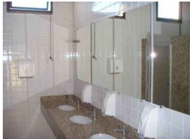
Figura 31 – Construção de banheiro na Biblioteca
