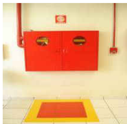
Figura 21 – Instalação de Sistema de Prevenção e Combate a Incêndio Bloco L
