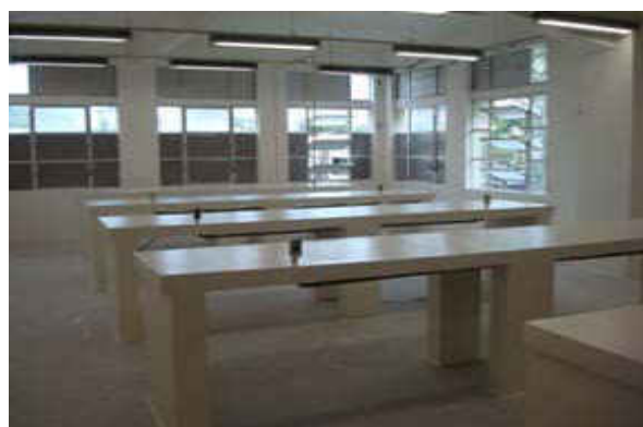
Figura 27 – Reforma das Instalações no Bloco N na Sede Centro
