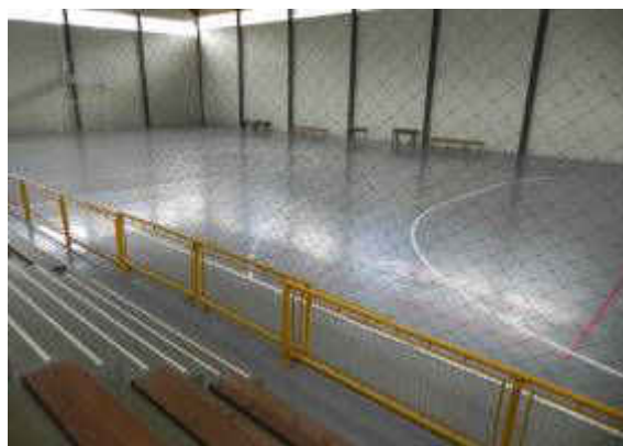
Figura 37 – Recuperação do piso da quadra poliesportiva
