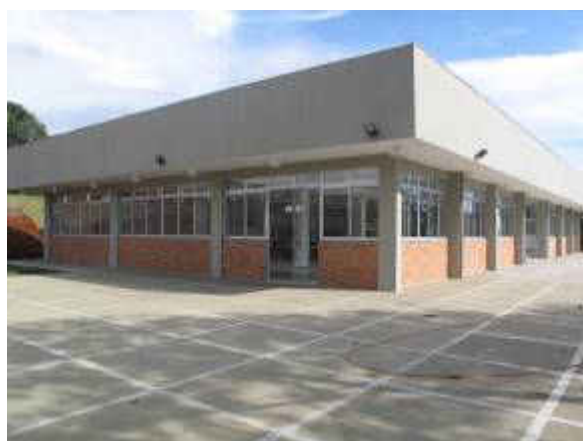
Figura 35 – Construção do RU
