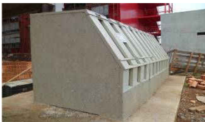
Figura 26 - Implantação de subestação de energia elétrica na Sede Ecoville
