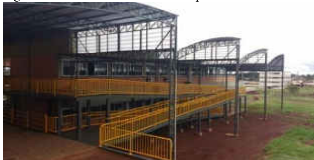
Figura 6.2.8-B.1 – Cobertura da rampa
