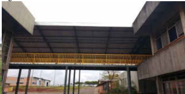
Figura 6.2.8-B.2 – Cobertura de acesso ao Bloco H
