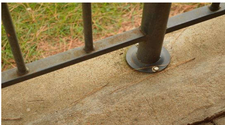
Figura 16: Outro ângulo do guarda-corpo, localizado ao lado do ginásio de esportes, apresentando focos de oxidação e revelando o tipo de aço como sendo carbono.
