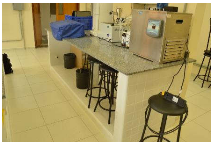
Figura 35: Bancada construída no espaço central do laboratório, composto de alvenaria, com acabamento em azulejos cerâmicos, conforme padrão usual da UTFPR.
