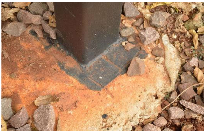
Figura 27: Vinculação dos pilares com o solo.
