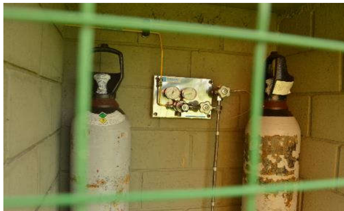
Figura 47: Interior da central de gases com utilitários do sistema de escoamento de gases
