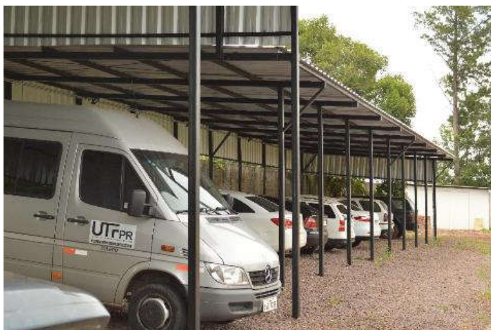
Figura 25: Visão geral da estrutura de cobertura licitada no pregão 16/2015.
