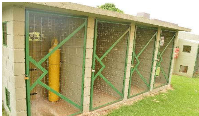
Figura 44: Central de gases executada em blocos de concreto.
