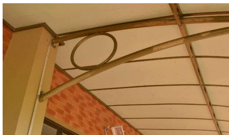
Figura 7: Verificou-se que os materiais componentes da estrutura, portanto do toldo, eram de aço carbono, com acabamento em pintura de esmalte sintético.
