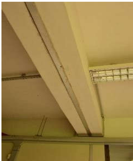
Figura 42: Conforme constatado in loco as juntas instaladas são do tipo JENEE.
