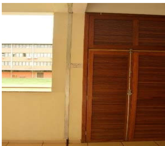
Figura 40: Nas paredes, as juntas possuem um acabamento em perfil metálico de alumínio.
