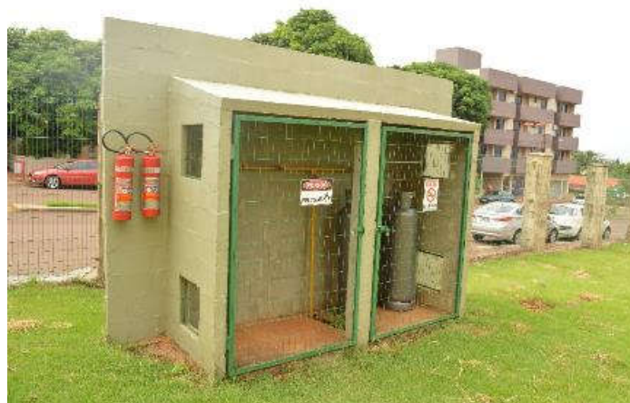
Figura 46: Central de gases executada em blocos de concreto
