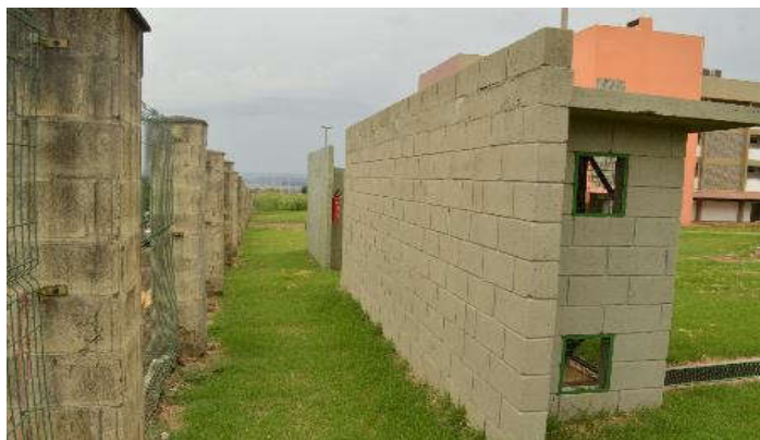
Figura 44: Central de gases executada em blocos de concreto.
