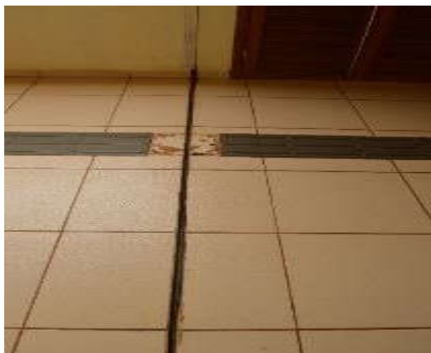
Figura 39: Localização da junta sob o piso.
