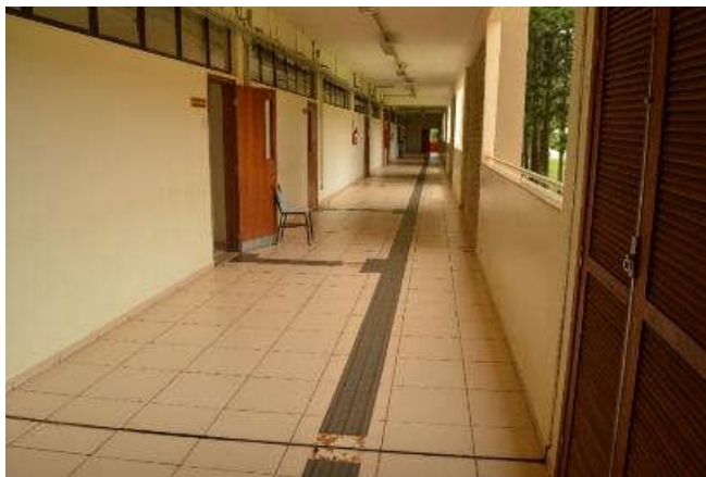
Figura 39: Localização da junta sob o piso.
