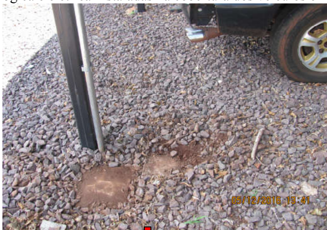
Figura 20: Caixas de lógica e elétrica instaladas na cobertura dos veículos oficiais.
