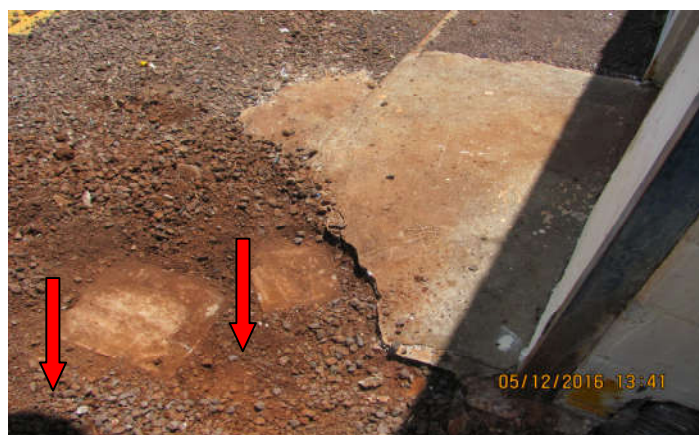
Figura 21: Caixas de lógica e elétrica instaladas no depósito do Câmpus.
